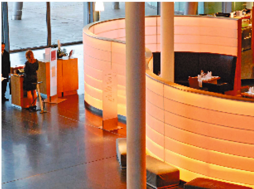
7 Für die Gläserne Manufaktur von Volkswagen in Dresden hat Koch Membranen eine Lichtwand entwickelt und gefertigt, die beidseitig mit einem Lichtgewebe bespannt und von innen dimmbar beleuchtet ist.
