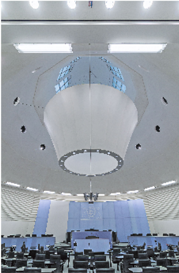
1–4 Der Baden-Württembergische Landtag hat während der Sanierung seines Landtagsgebäudes ein Übergangsquartier im Kunstgebäude Stuttgart in der Innenstadt bezogen. Für eine bessere Raumakustik sorgt dieser Lampenschirm mit einem Durchmesser von zirka 10 Metern. Zwei Lagen Artex-Licht- und Akustikgewebe auf einer trichterförmigen Aluminium-Konstruktion brechen die Schallwellen und minimieren die Nachhallzeit.“
